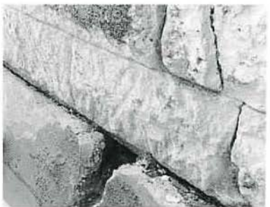
Détail du dégarnissage de joints extérieurs
